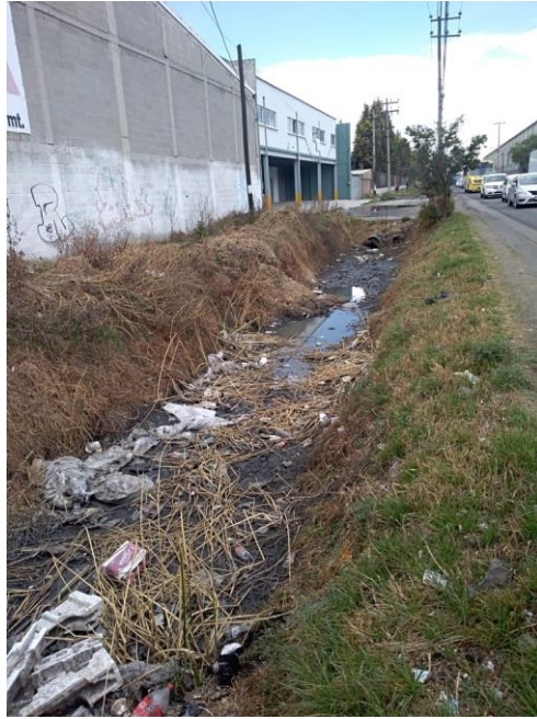
Ilustración 7 Estado actual de la Avenida
